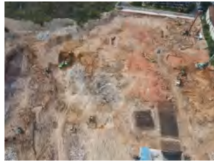
照片 3 项目区现状
