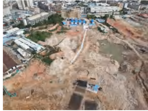
照片 2.1-2 项目区南侧现状
