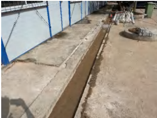
照片 5 工区内排水沟
