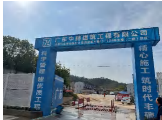
照片 2 施工出入口
