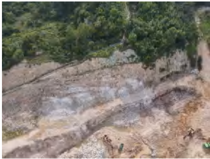
照片 2 西侧边坡现状
