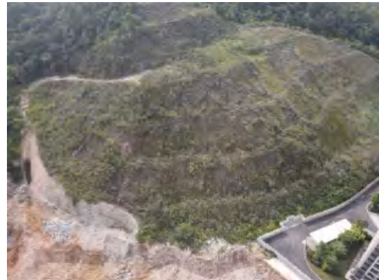
照片 6 一期边坡现状
