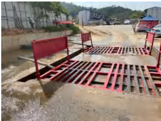
照片 3 洗车池和沉砂池
