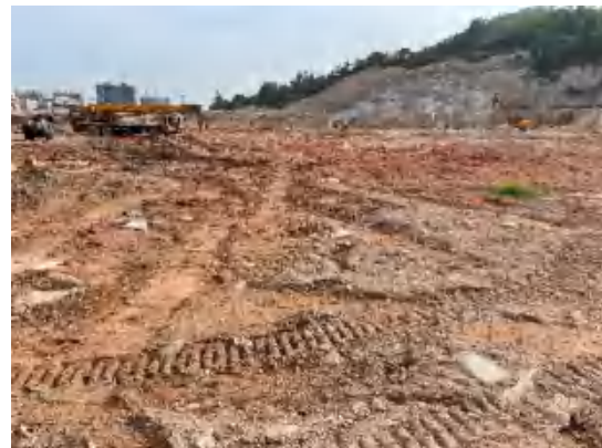
照片 4 二期施工现状
