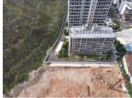
照片 1 北侧一期现状
