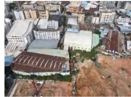
照片 4 东侧已建厂房现状
