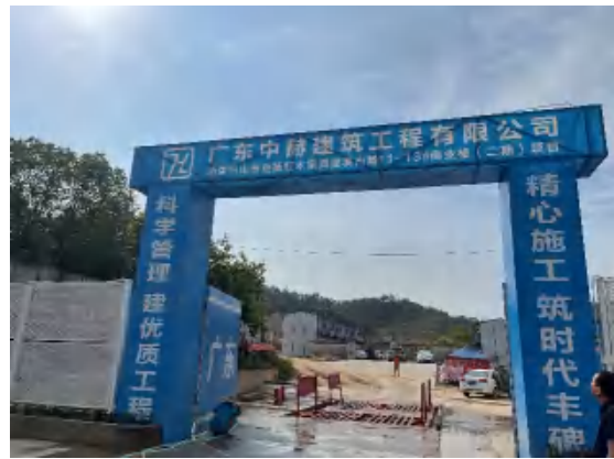
照片 2 施工出入口
