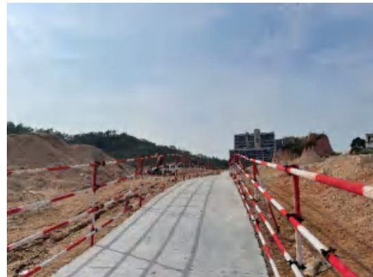
照片 8 施工临时道路
