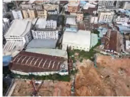
照片 2.1-4 项目区东侧现状
