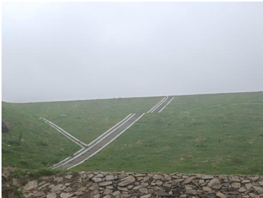
照片 3 大坝排水沟
