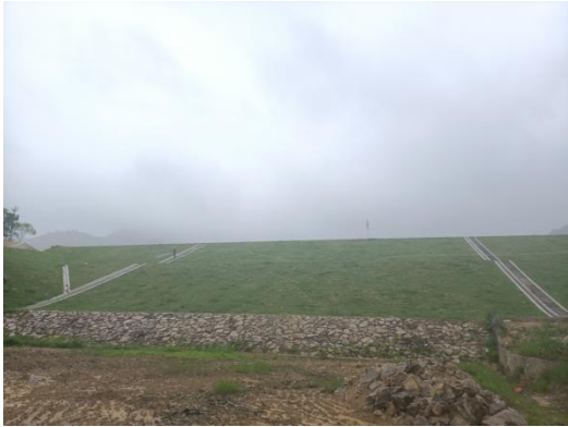
照片 1 大坝坝体
