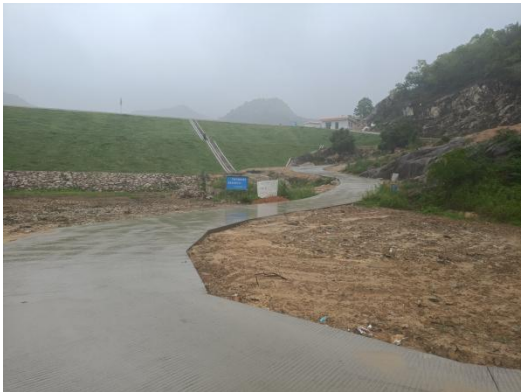
照片 5 上坝公路
