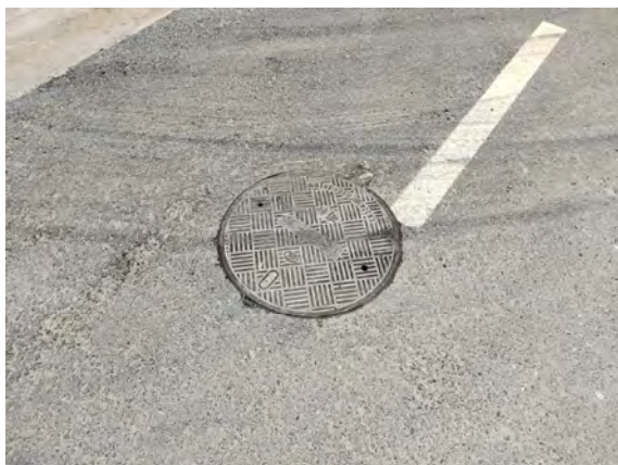
照片 15 7号区域已布设雨水检查井现状
