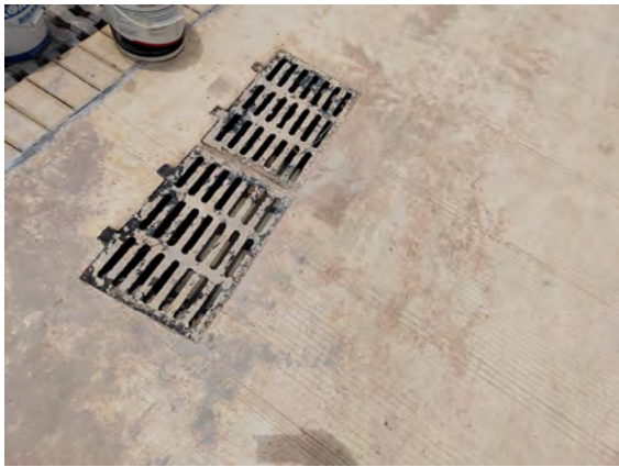
照片 16 7 号区域已布设雨水口现状
