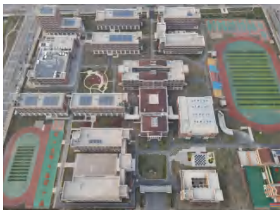
照片 1 项目区现状
