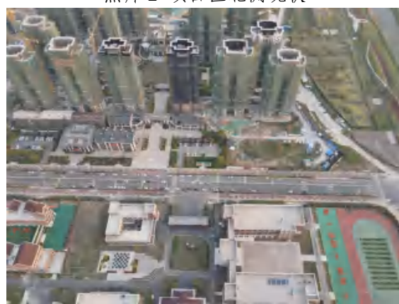
照片 4 项目区南侧现状
