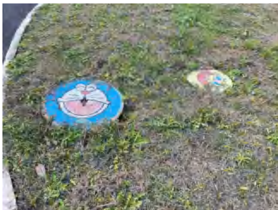
照片 1 雨水管网 1
