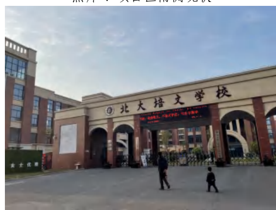
照片 6 学校南侧主出入口
