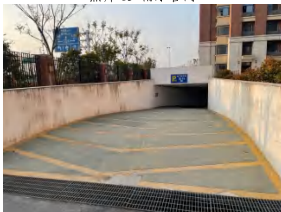
照片 17 地下车库出入口
