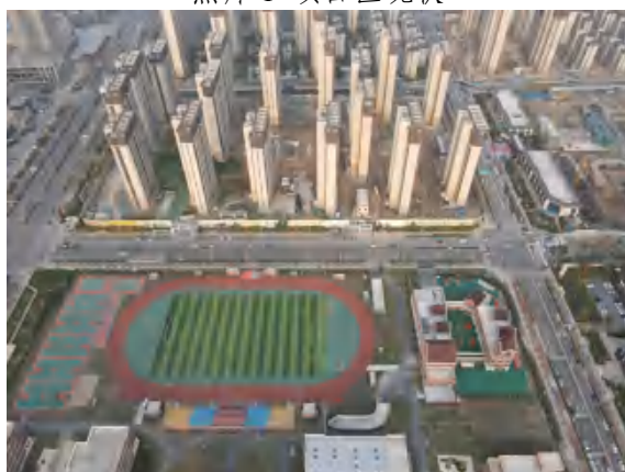
照片 3 项目区东侧现状
