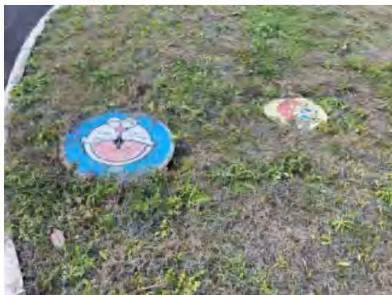
照片 15 雨水管网
