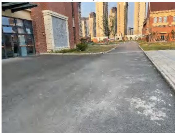
照片 9 内部道路
