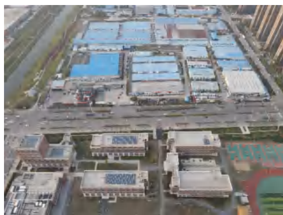
照片 2 项目区北侧现状
