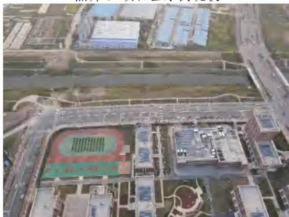
照片 5 项目区西侧现状
