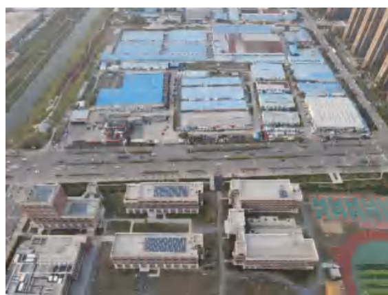
照片 2 项目区北侧现状
