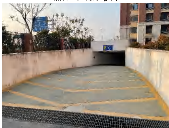
照片 17 地下车库出入口
