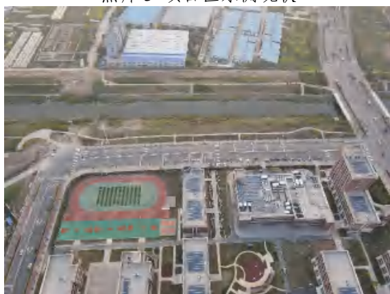
照片 5 项目区西侧现状
