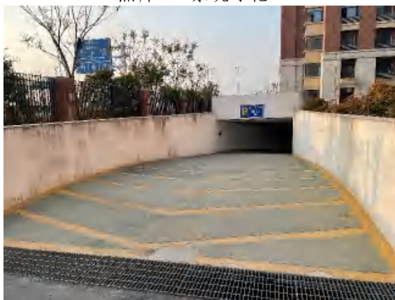
照片 13 地下车库出入口
