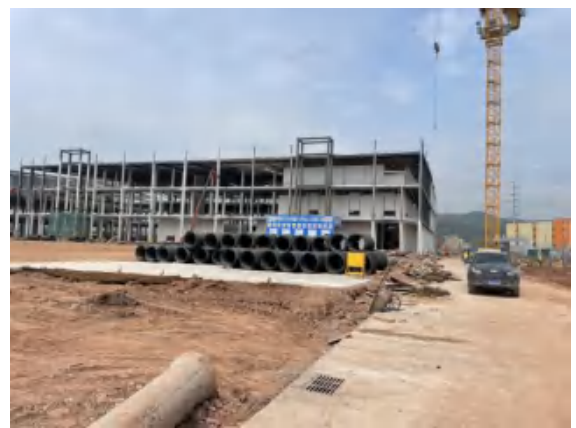
照片 10 化成一车间建设现状
