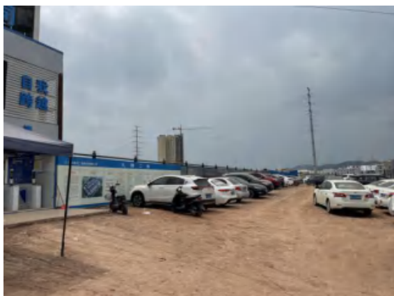
照片 13 代征不代建用地区域部分扰动 (施工围蔽外出入口处, 临时停放车辆)
