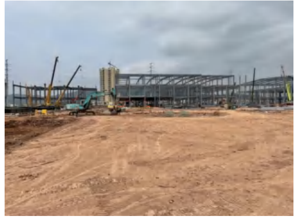
照片 8 项目内部现状
