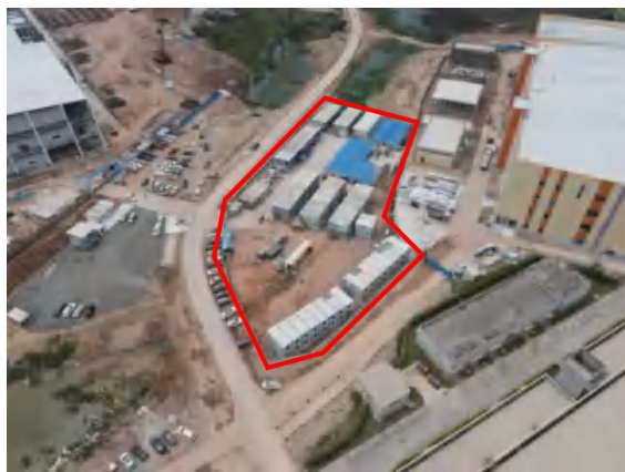
照片 6 北侧施工生产生活区航拍
