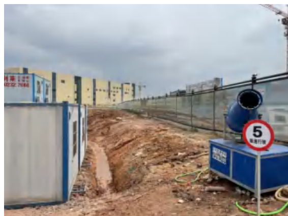
照片 14 代征不代建用地区域部分扰动 (施工围蔽外出入口处, 临时堆放材料)
