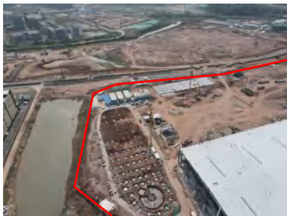
照片 4 项目场地现状-4 (靠近水域侧, 存在 2m 边坡)
