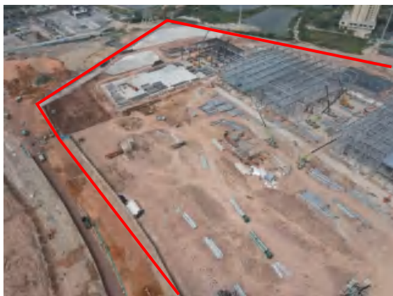
照片 3 项目场地现状-3 (左侧与规划道路相衔接)
