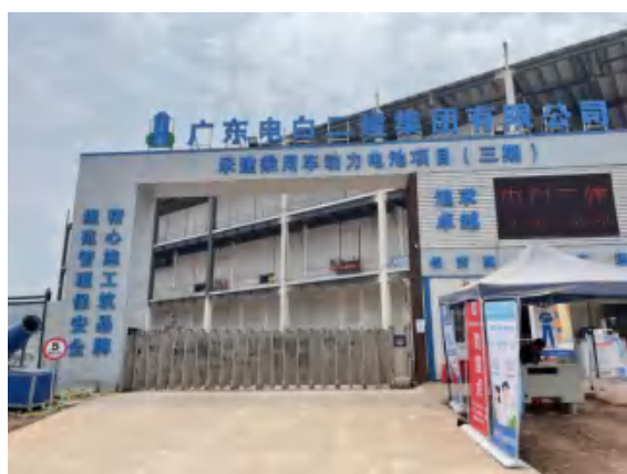
照片 15 代征不代建用地区域部分扰动 (作为施工出入口的部分, 地面已做硬化)
