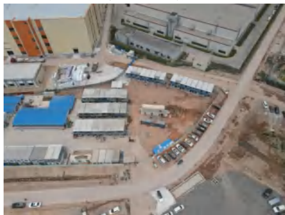
照片 4 施工生产生活区航拍
