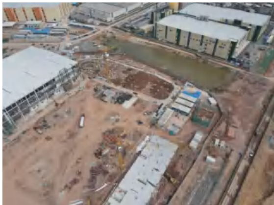
照片 1 项目区航拍
