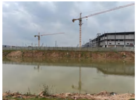
照片 12 项目区红外线北侧低洼地 (边坡为代征不待建区域，本项目建设过程中不扰动)
