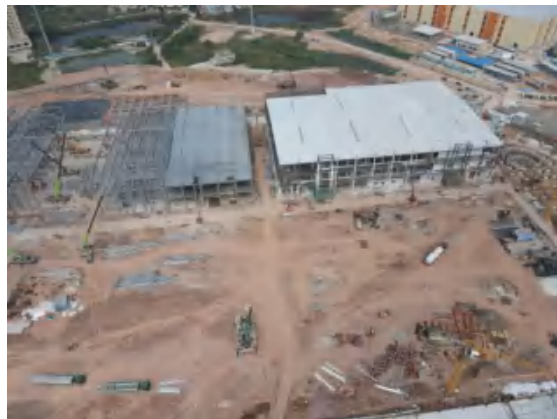
照片 2 项目区航拍
