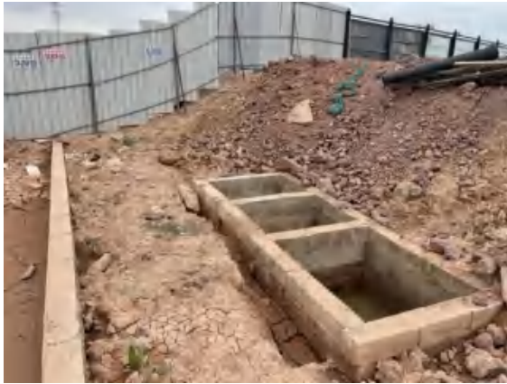
照片 7 项目东侧施工出入口沉沙池
