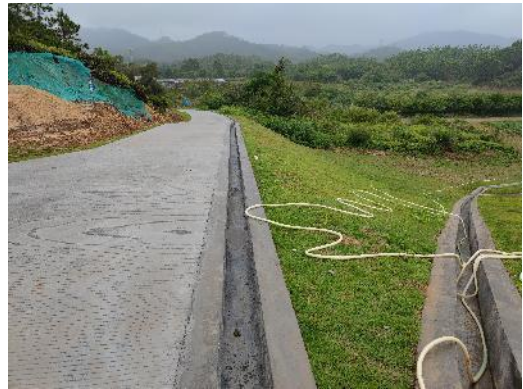
照片4 大坝排水沟与道路排水沟
