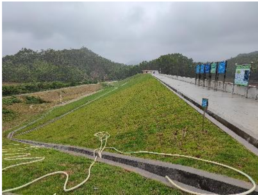
照片3 大坝排水沟
