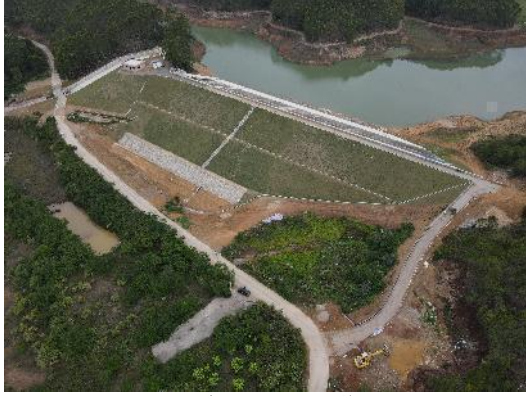
照片1 大坝坝体
