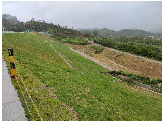
照片6 坝体植草护坡
