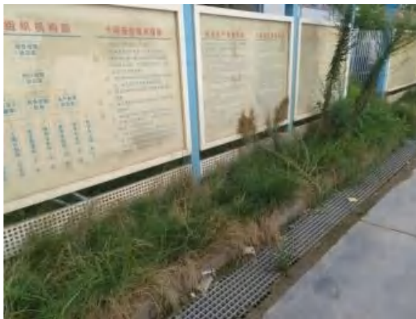
照片 3 临时防护工程-排水工程-场地排水沟
