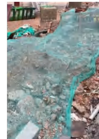
照片 4 临时防护工程-覆盖工程-密目网覆盖
