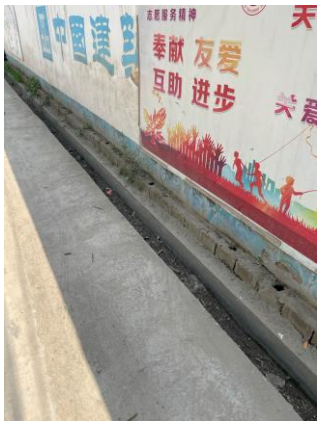
照片 5 场外施工生产生活区排水沟
