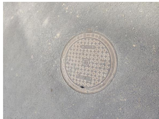
照片 2 项目区雨水井
