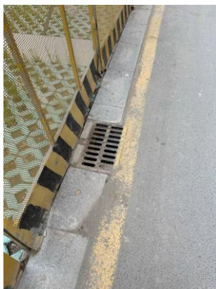
照片 1 项目区雨水口
