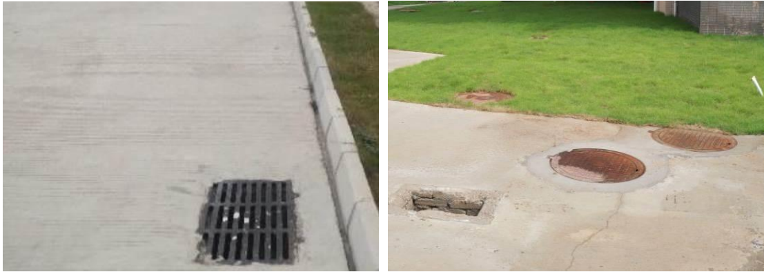
图 3.5-1 工程措施现状照片
